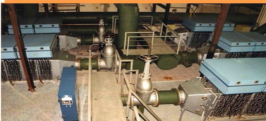
Установка ультрафиолетового обеззараживания воды на сооружениях водоподготовки в г. Череповце
