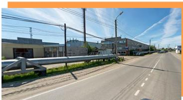
Прокладка тепловых сетей в промышленной зоне в г. Нефтеюганске: надземная на опорах и подземная в местах пересечения транспортных путей
