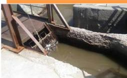
Аварийное состояние сооружений механической очистки стоков на первой очереди канализационных очистных сооружений в г. Волжском до реконструкции
