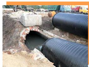
Замена трубы канализационного коллектора в г. Волжском путём протаскивания внутрь старого свода без раскопки траншеи
