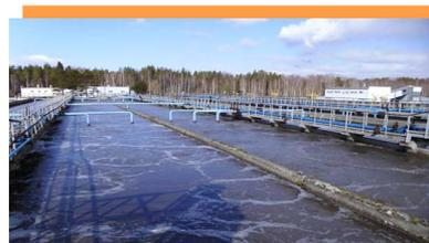
Аэротенки биологической очистки на очистных сооружениях канализации в г. Череповце после модернизации воздуховодного и насосного оборудования
