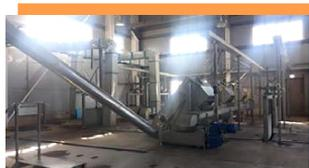
Оборудование для механической очистки стоков, установленное в здании решёток биологических очистных сооружений в г. Волжском
