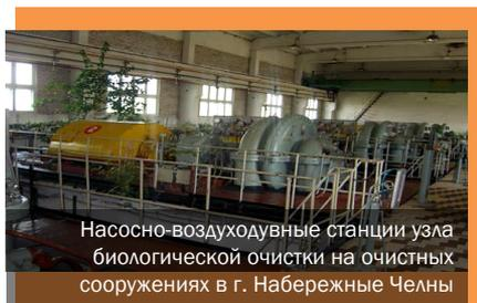
Насосно-воздуходувные станции узла биологической очистки на очистных сооружениях в г. Набережные Челны
